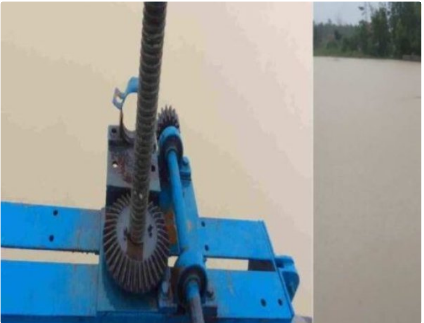
Pintu air Albaret Simpang Mesuji
